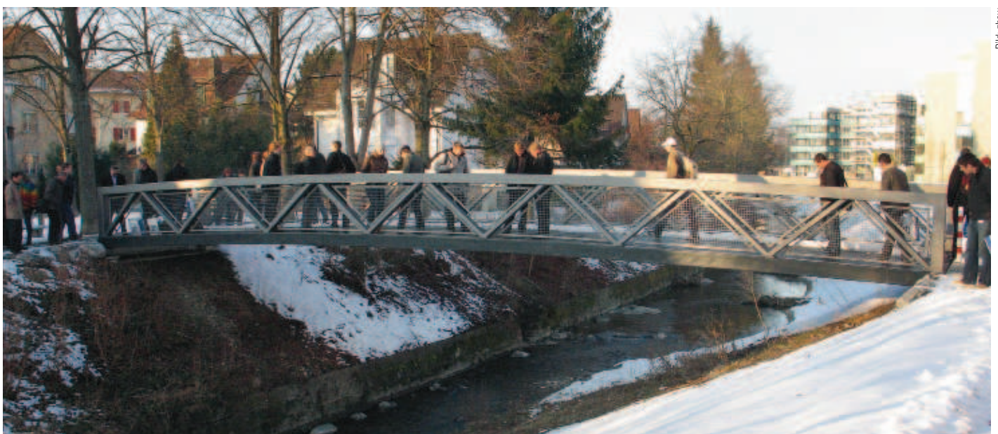
Die Fussgängerbrücke ist eine Stahl-FVK-Verbundkonstruktion: Fachwerk und Obergurt sind aus Stahl, die als Untergurt funktionierende Fahrbahnplatte aus FVK.
