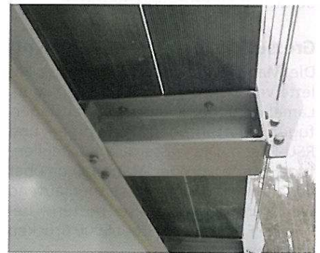
Befestigung der Bohlen und der Geländerpfosten auf die Querträger.
